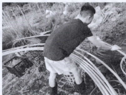
農場拆除溫室
